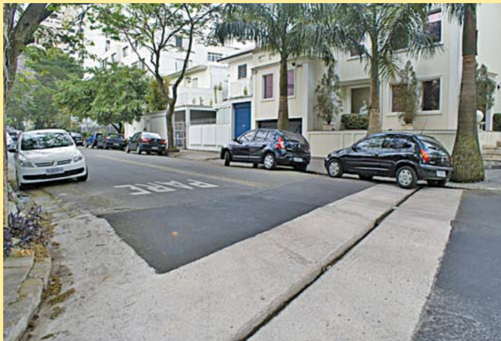
Sarjetão da alameda dos Guaramonis com avenida Iraí: um dos nove entregues
