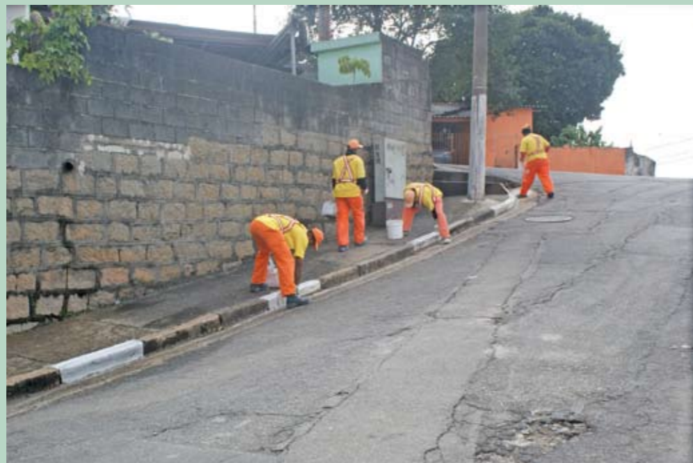
Funcionários trabalham na rua Doutor Osvaldo Urioste, na Vila Pereira Barreto, em Pirituba
