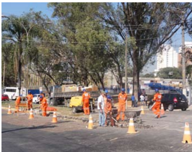
Avenida Kenkiti Shimomoto: obras para prolongar a ilha
