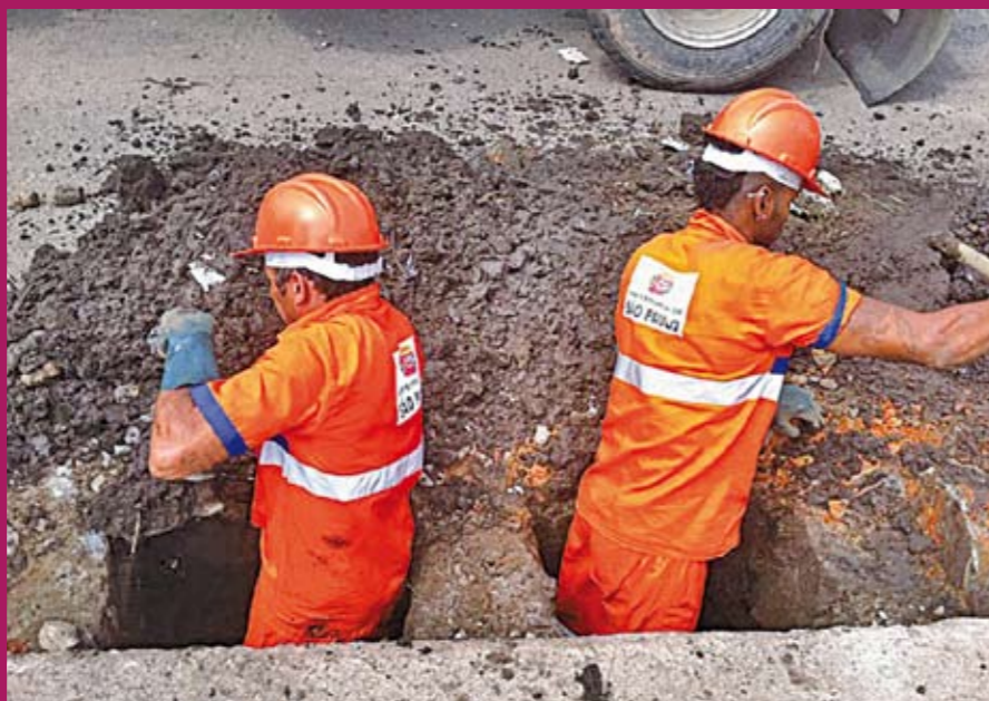
Funcionários fazem a limpeza de boca-de-lobo
