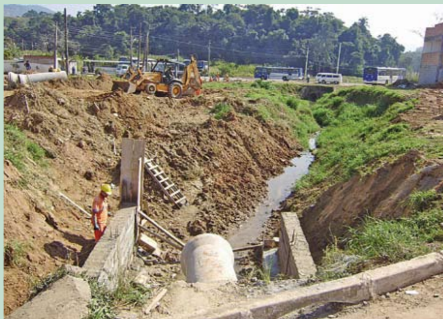
Construção dos muros de arrimo no córrego Flor de Maio, no Jaçanã
