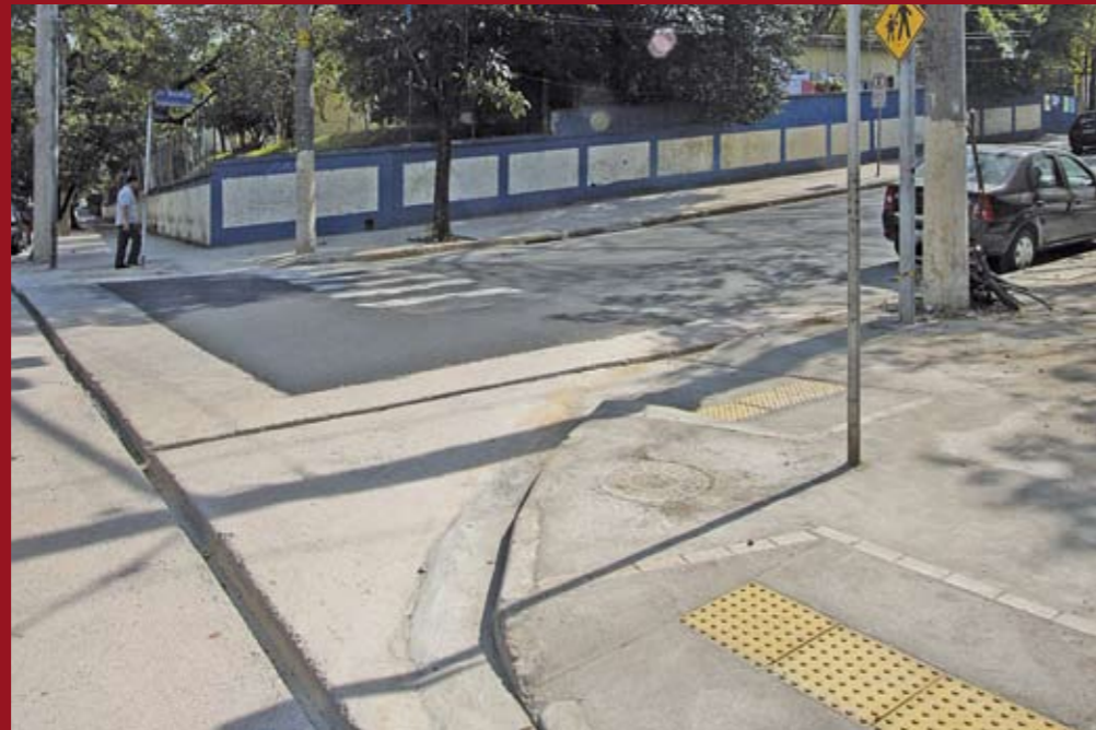
Esquina das ruas Loeffgren e Doutor Bacelar: itens de acessibilidade instalados
