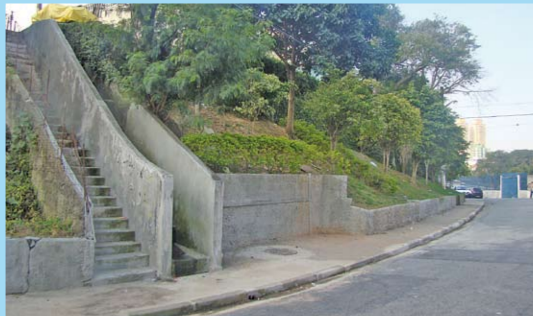
Uma das escadarias reformadas, guias, sarjetas e calçada feitas em rua do Tucuruvi
