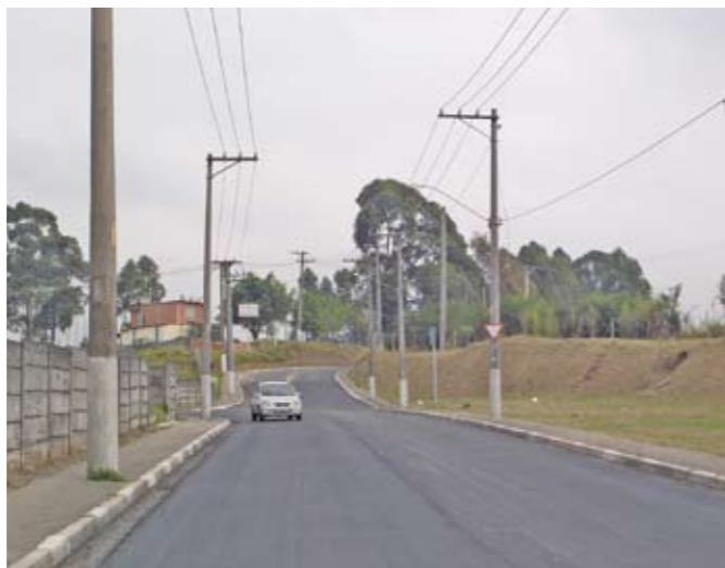
Trecho da rua Mogeiro que ganhou nova camada de asfalto
