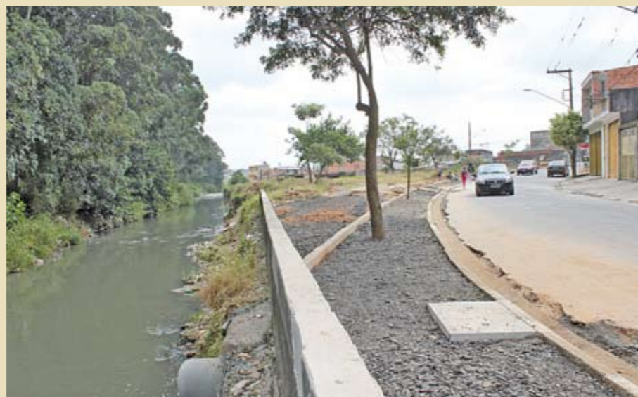
Rua Baltazar de Azevedo: galerias ampliadas
