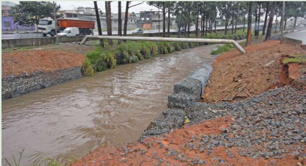
Contra deslizamentos: muro de gabião combate erosão da margem
