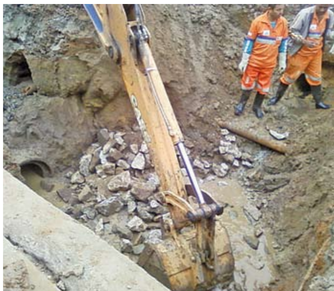
Tubulações: assentamento e troca de canos
