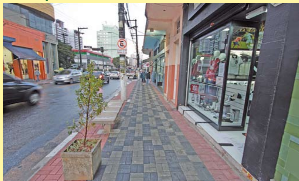
Rua Vergueiro: 370 metros de piso intertravado
