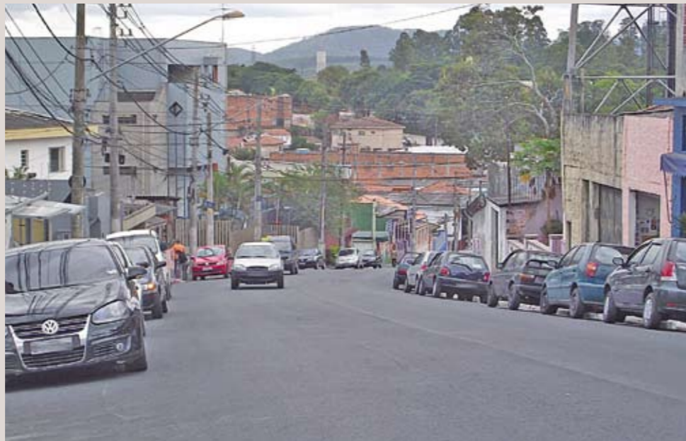
Trecho da rua Mogeiro já com asfalto novo. Vem mais recapeamento por aí
