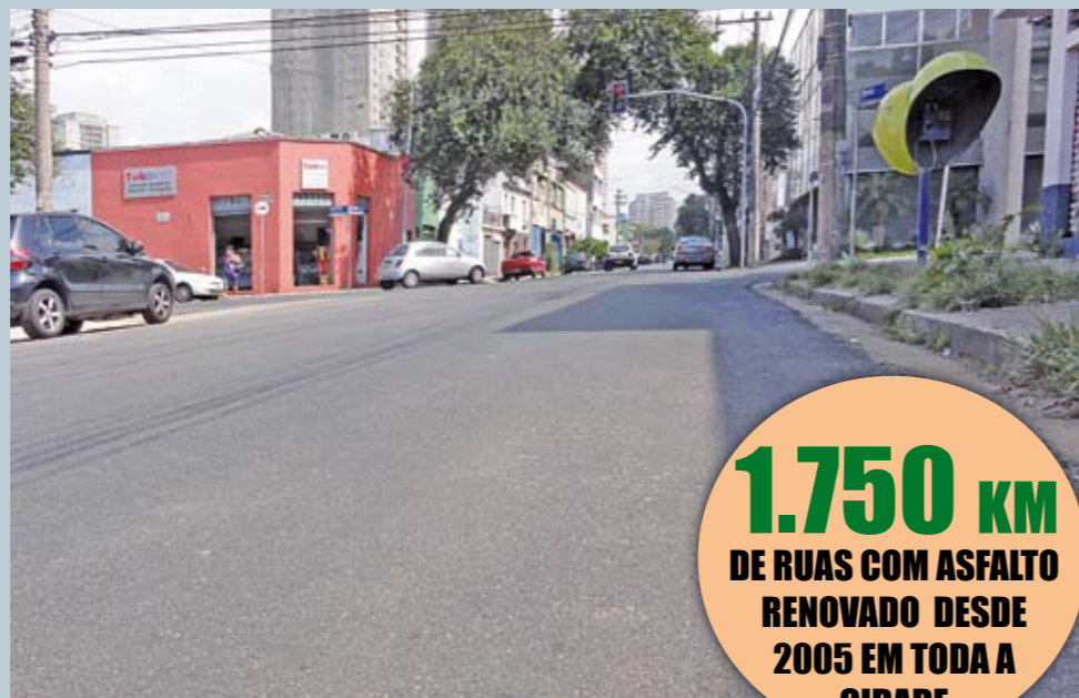
Rua Roma: trecho de 735 metros recapeado
