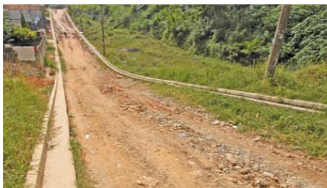
Rua Ilha dos Pássaros: depois da tubulação de esgoto, pavimento
