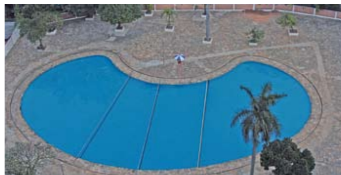
Depois da reforma, vazamento da piscina foi fechado
