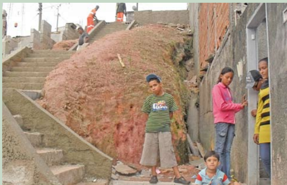
Nova escadaria: concreto no lugar da terra batida
