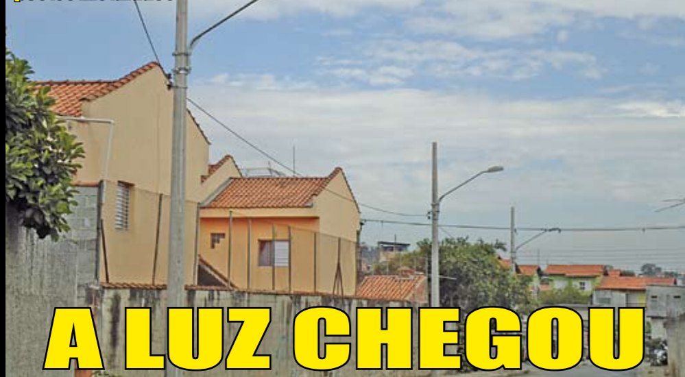
Rua Paulino Augustin: postes instalados
