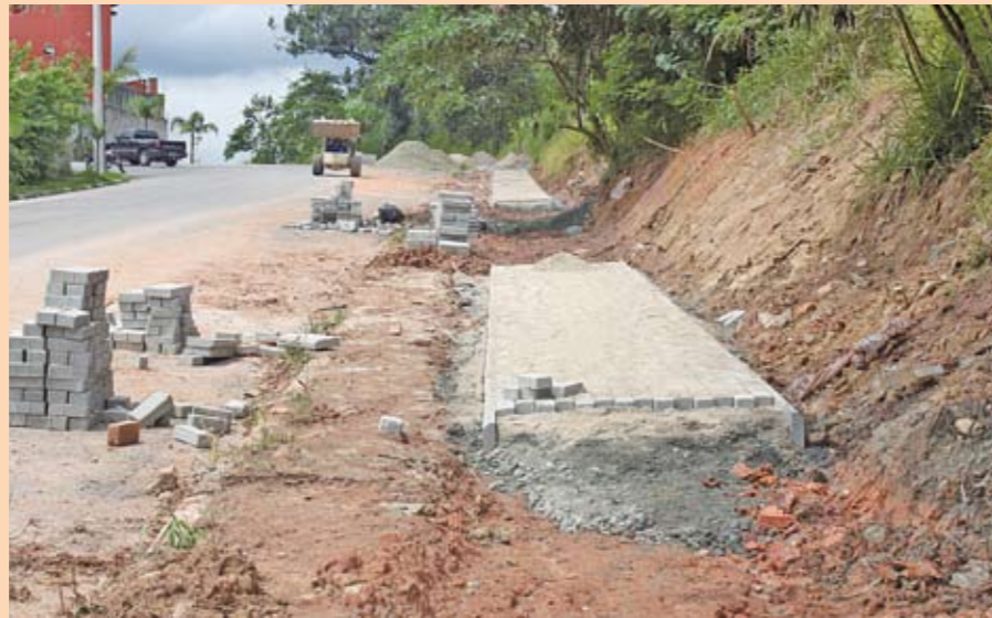
Implantação de calçada verde em todo o perímetro do novo parque
