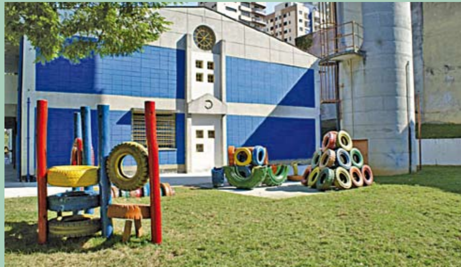
CEI Benjamin Antonio Salles: plantio de grama, substituição de telhas e piso cerâmico
