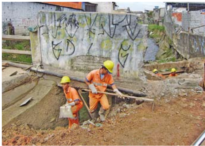
Homens trabalham na construção de muro de arrimo
