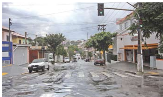
Rua da Imprensa terá asfalto novo em toda sua extensão
