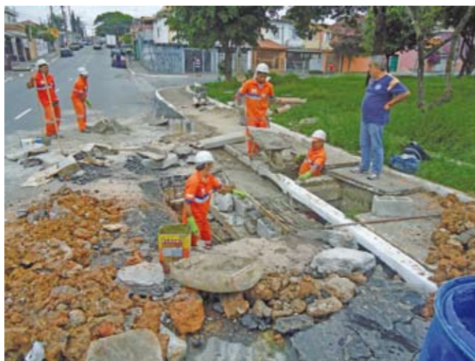
Via em obras: equipe trabalha para liberar a rua rapidamente
