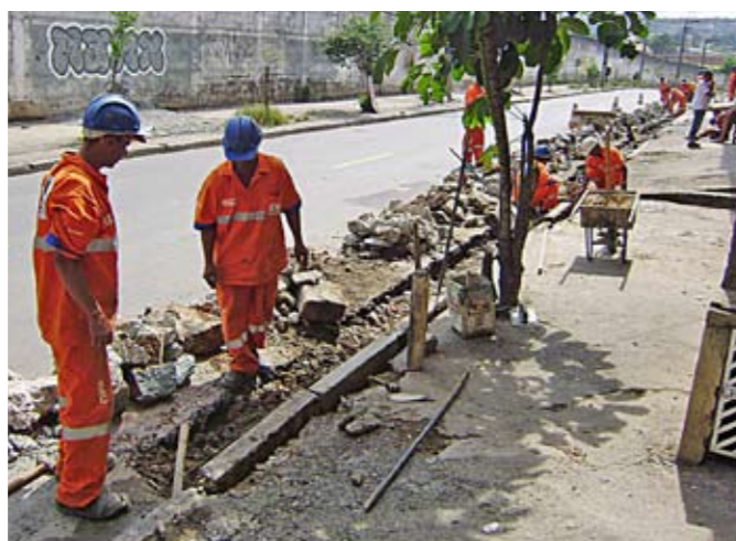
Guias e sarjetas em obras na rua Ushikichi Kamiya, no Tremembé
