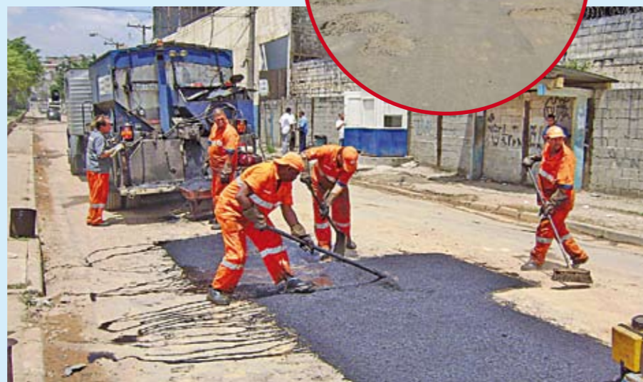
Estrada Três Cruzes recebe asfalto transportado pelo caminhão: temperatura certa
