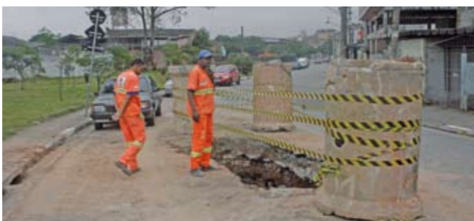
Rua Antônio de Pinho de Azevedo: fim da interdição
