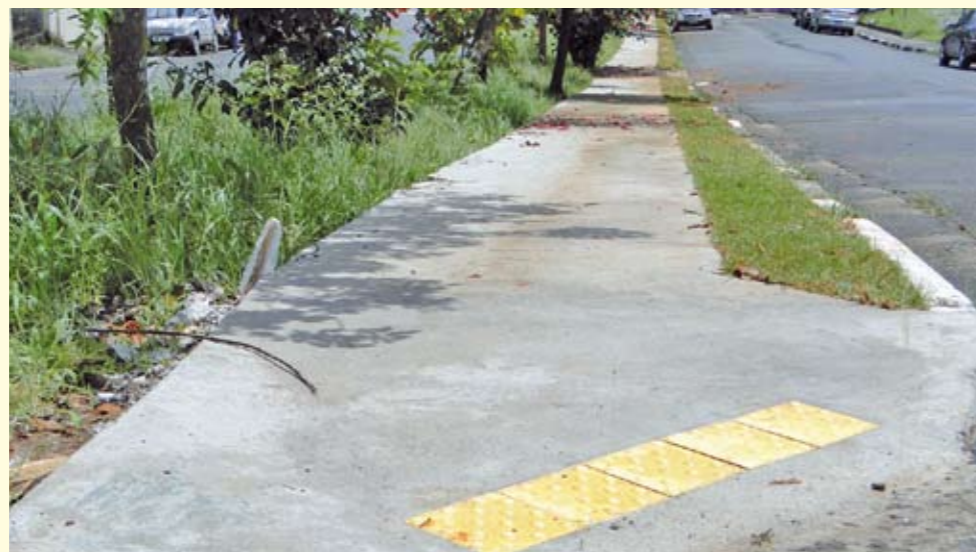
Novos passeios: concreto bem liso e piso especial para deficientes visuais
