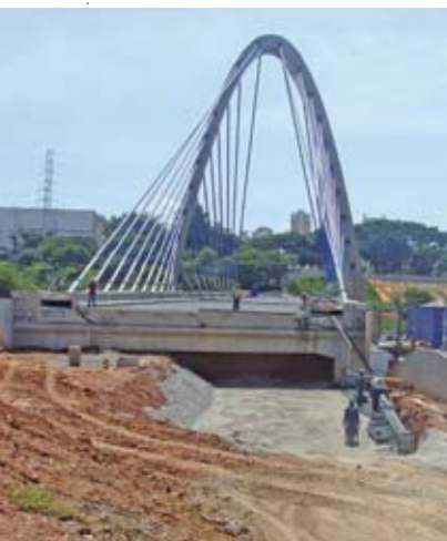
Ponte estaiada: quase pronta
