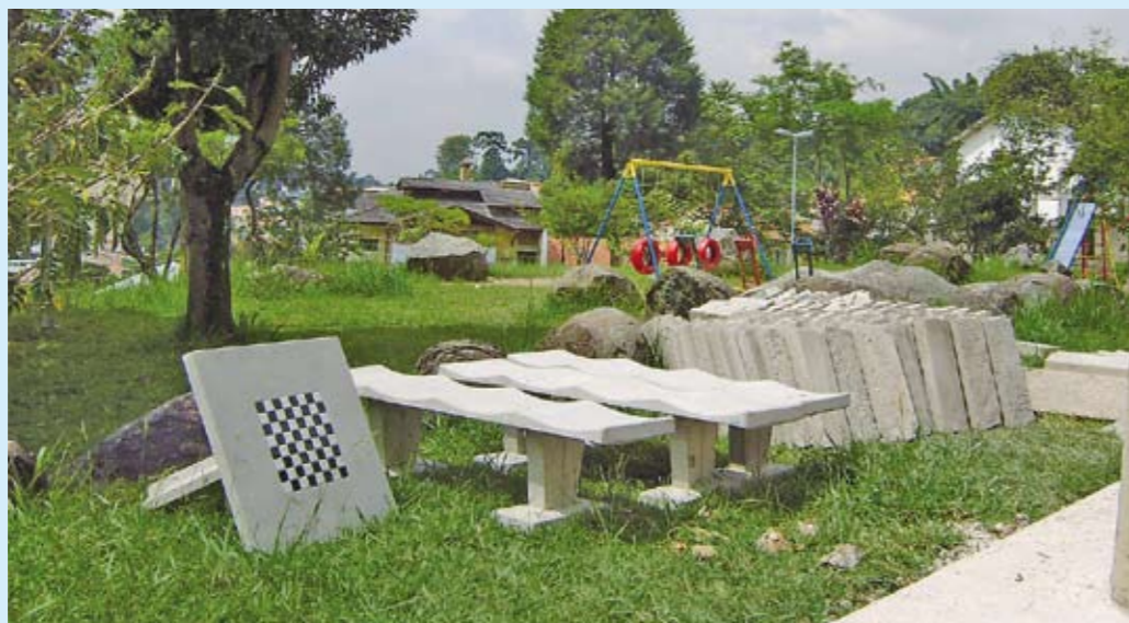
Materiais que serão instalados na praça Maria Dias Mendes, na Vila Albertina
