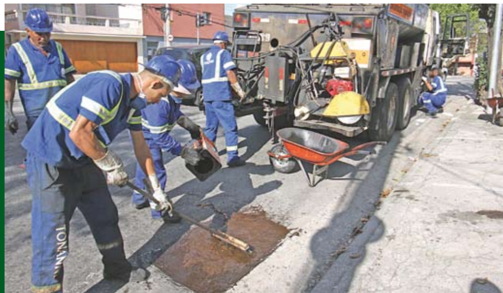
Operários trabalham em obra de conserto de buraco
