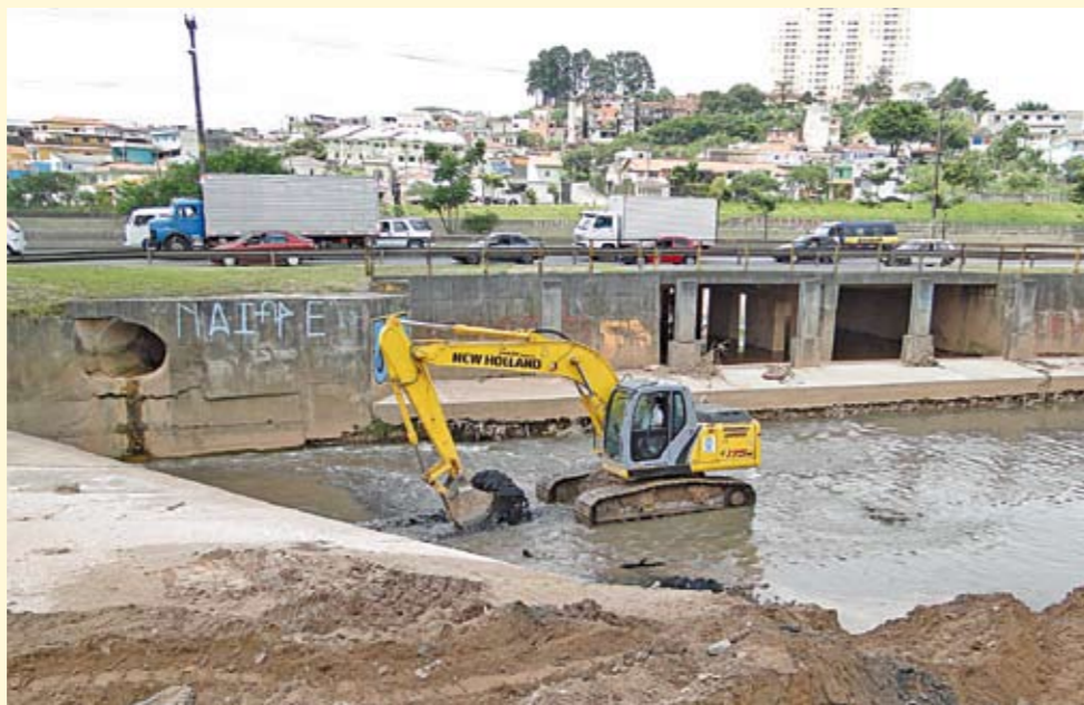
Escavadeira tira sujeira do leito do Aricanduva: prevenção de transbordamento
