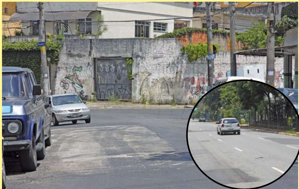
Rua Ramal dos Menezes (foto maior) e av. Olavo Fontoura (menor): trechos com asfalto novo em breve
