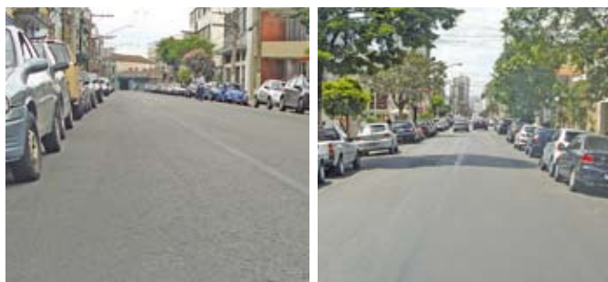
Ruas Belém e Coelho Lisboa: mais de mil metros de asfalto novo
