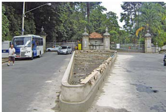
Rotatória construída na frente do Horto: trânsito mais organizado
