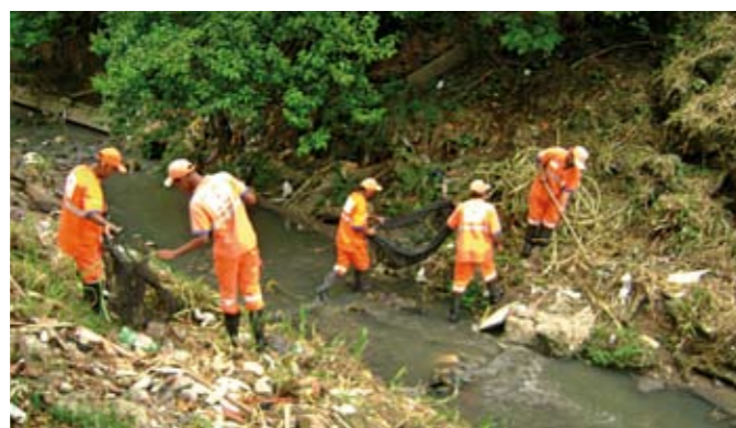
Limpeza manual: coleta de entulho jogado nas margens dos córregos
