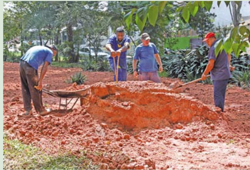
Praça Centenário, na Casa Verde: área de lazer em construção
