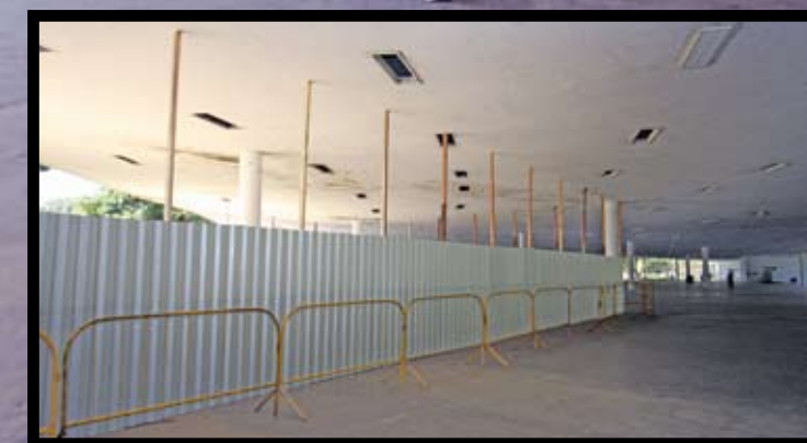
Área interditada: já em obras
