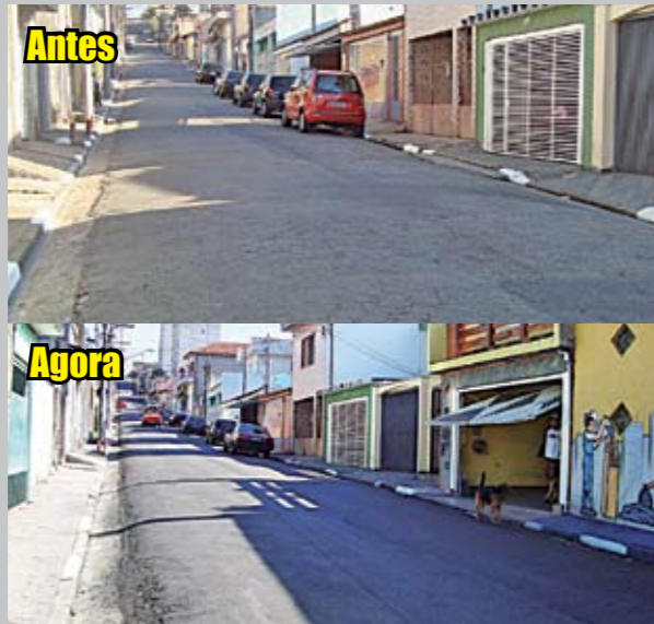
Rua Major Dantas Cortez: 1.620 metros recapeados
