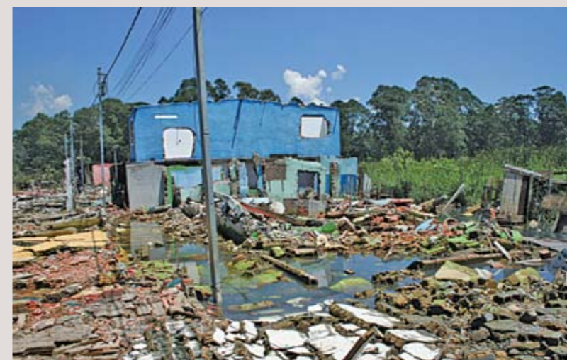
Demolição: 449 residências condenadas já foram destruídas para evitar invasões
