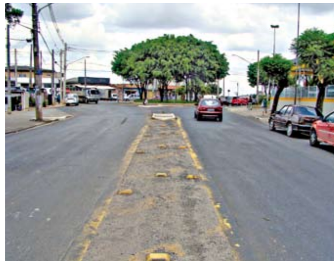
Avenida Satélite recapeada: fim dos buracos
