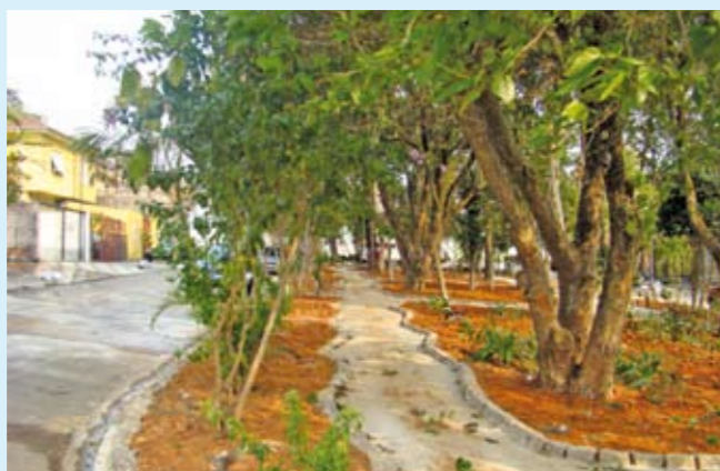
Praça Francisco Glicério: passeios, guias e terreno nivelado
