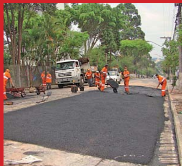
Serviço de tapa-buraco feito no Tucuruvi
