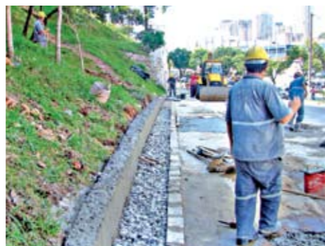
Canaleta vai melhorar a drenagem no local
