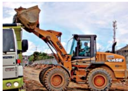
Entulho retirado de ponto de descarte ilegal
