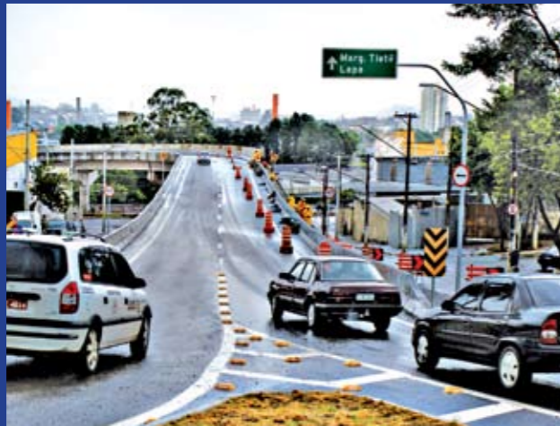
Motoristas seguem pela nova alça, no sentido capital
