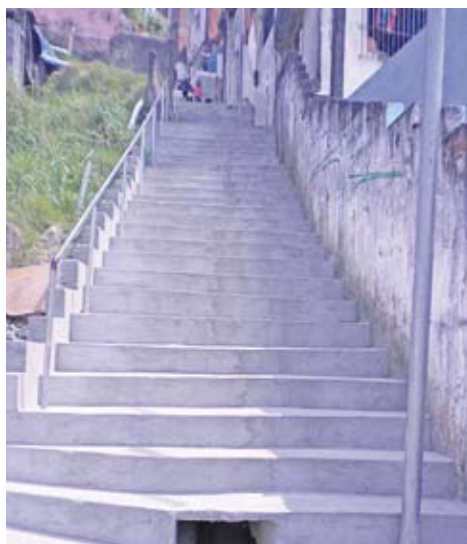
Vielas Bento Rodrigues: reformada
