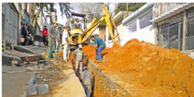
Rua Dança Cigana: tubos de concreto trocados
