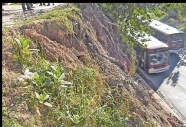
A encosta: com a obra quase pronta (no alto), fim do perigo.
