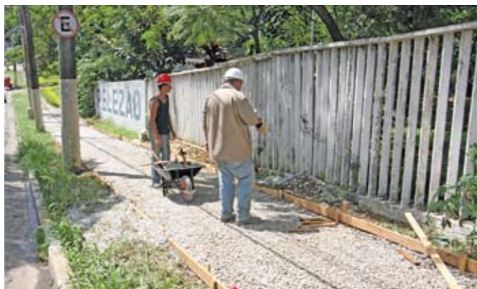
Calçada do Clube Escola Lapa: troca do piso
