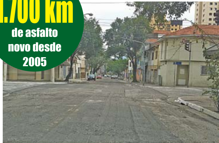
Rua Caio Graco: 846 metros estão sendo recapeados
