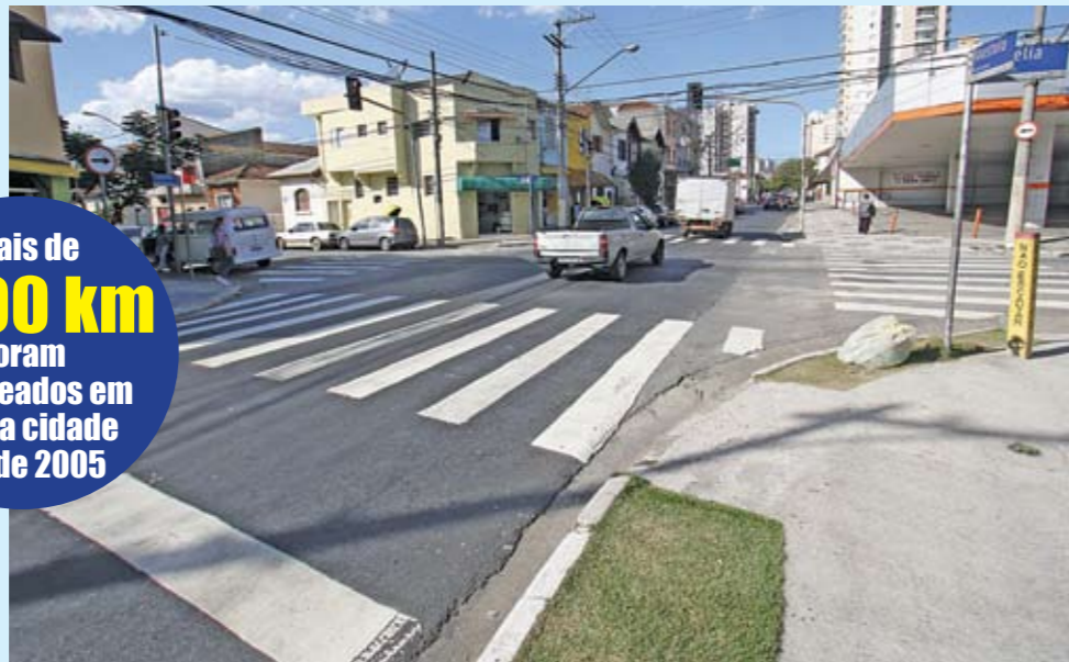
Rua Faustolo: recapeamento em toda a extensão
