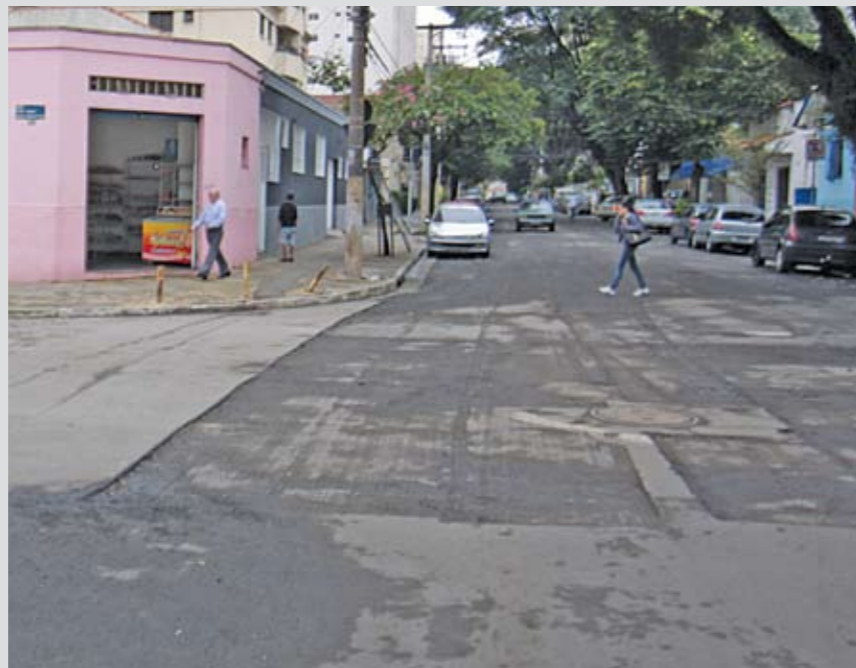
Rua Fábria: recapeamento está quase pronto
