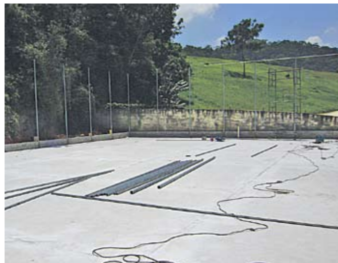
Quadra em construção em Clube da Comunidade do Tremembé
